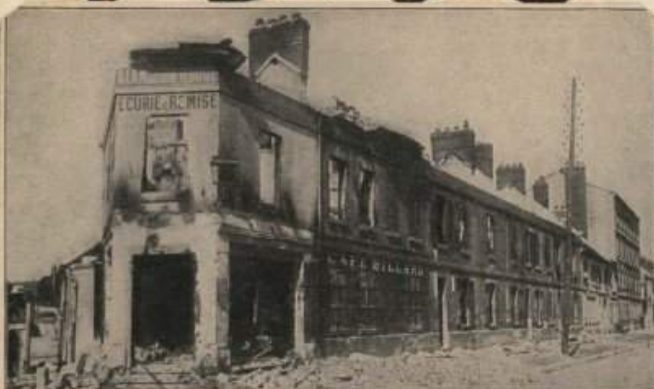
Beschädigungen in Toul, einem Ort etwa 50 Kilometer von Paris, den deutsche Truppen im August 1914 eroberten.
