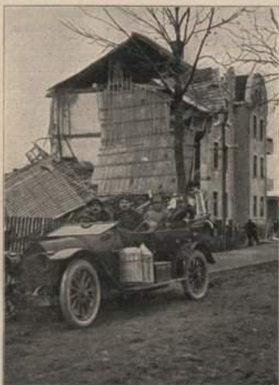
Durch Granaten zerstörtes Haus in Michallen.
